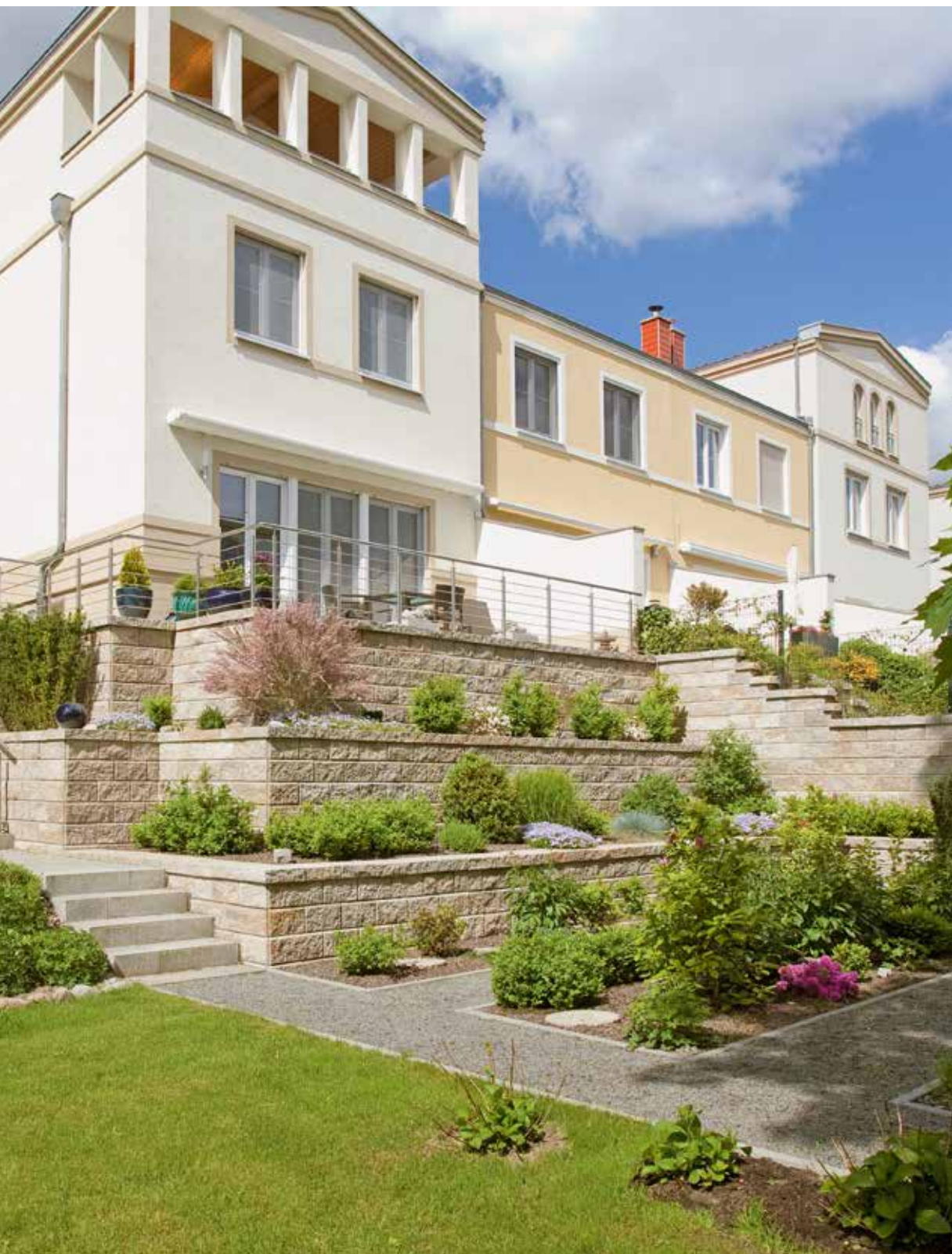
ALLAN BLOCK® Muschel-Kalk nuanciert 87° Normal-, Eck- und Abdecksteine
